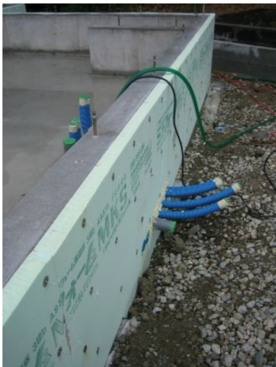
設備ピットの配管工事も始まりました。
