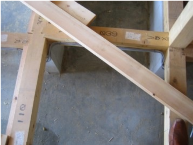
電気の床下配線も進んでいます。
