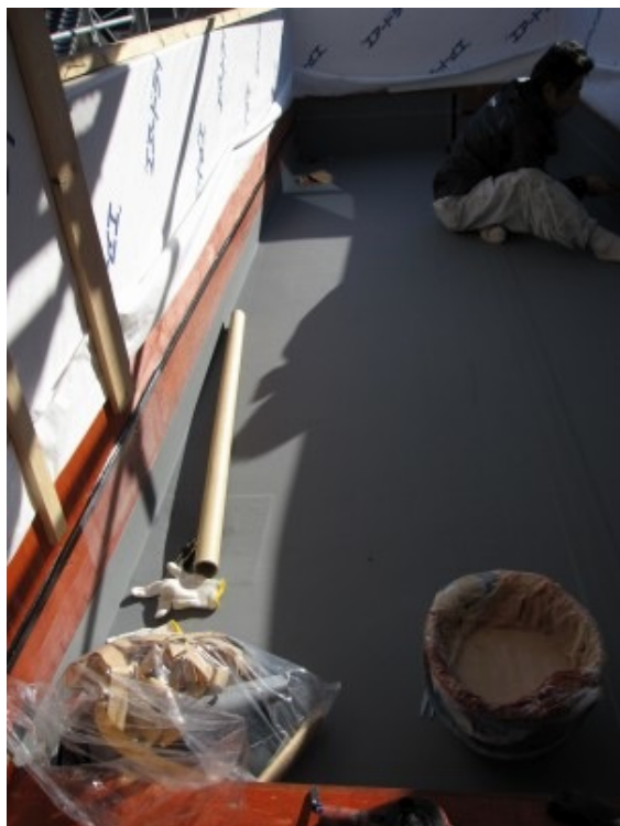
屋上防水工事中！
